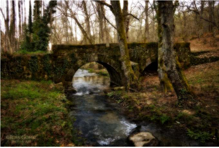
El puente de la Dehesa, Arroyo de El Coso, Cepeda
